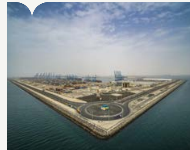
Khalifa Port Client: ThyssenKrupp Brand: ThyssenKrupp | Quantity: 06
